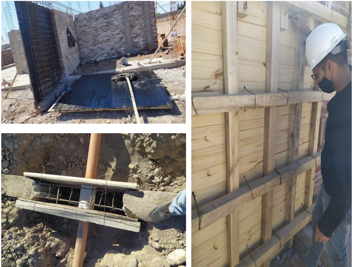
Figura 26. Verificación de pintado para desencofrado, dimensiones y verticalidad
