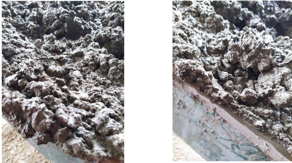
Figura 9. Hormigón H-25, se pueden apreciar las fibras y microfibras
