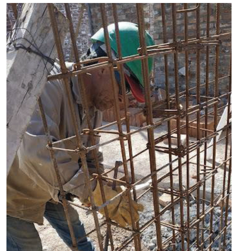
Figura 24. Acopio de armadura (izquierda) y armador confeccionando estribos para tabique (derecha)
