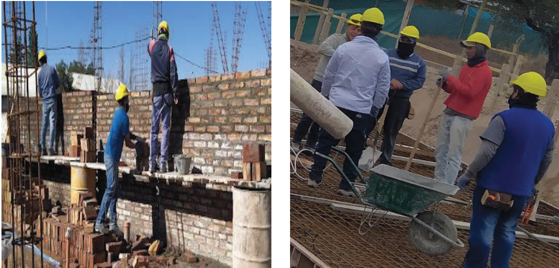
Figura 12. Obreros usando calzado y casco de seguridad
