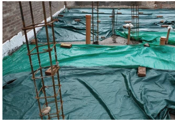
Figura 29. Curado de hormigón de contrapiso con tela media sombra
