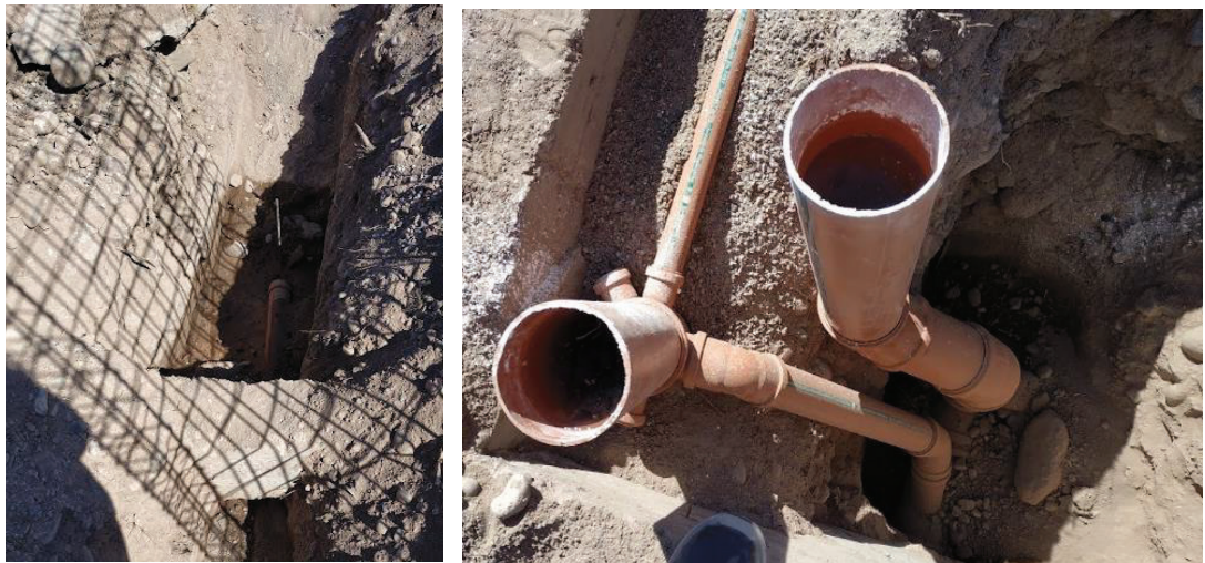
Figura 31. Prueba hidráulica de desagüe cloacal
