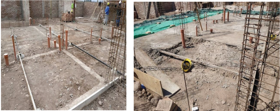
Figura 28. Reglas metálicas guía de contrapiso
