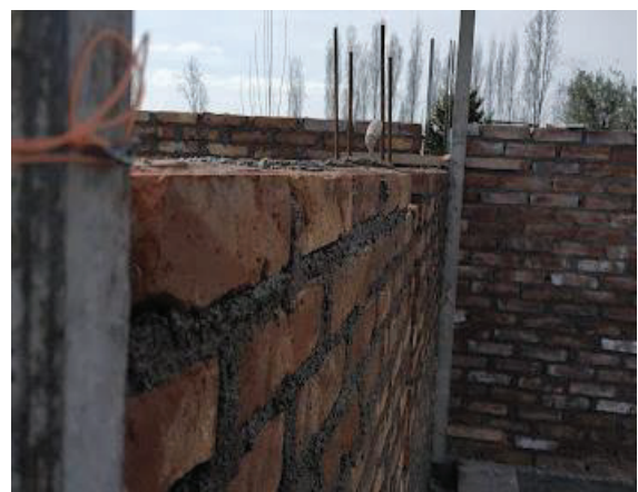
Figura 22. Muros de mampostería en construcción con sus reglas metálicas y tanzas guía
