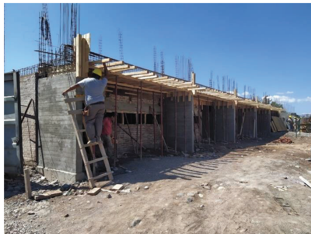
Figura 27. Apuntalamiento de encofrado de losa con puntales metálicos
