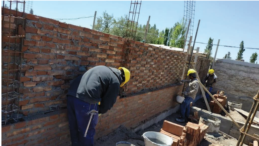
Figura 23. Construcción de muro doble de mampostería
