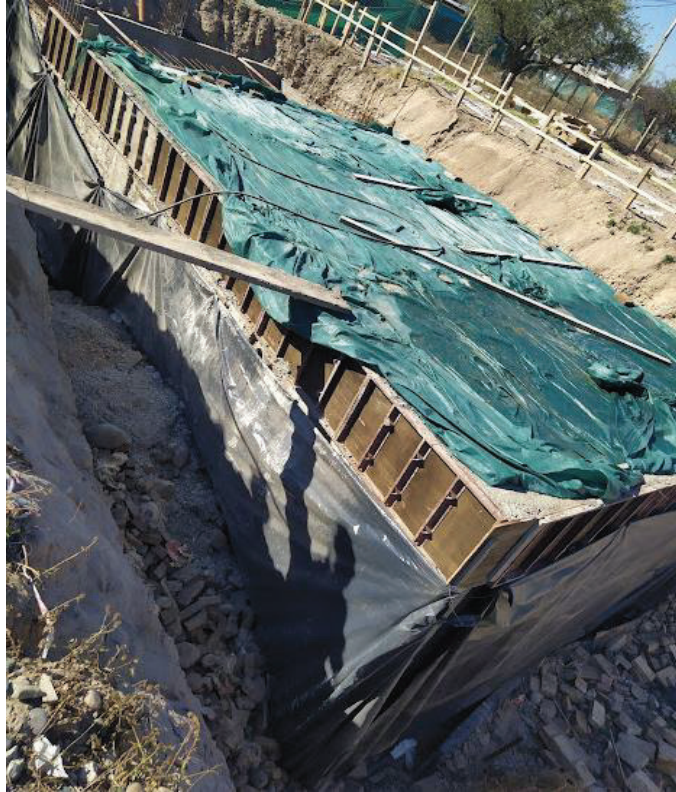
Figura 7. Curado de la losa de la sala de máquinas
