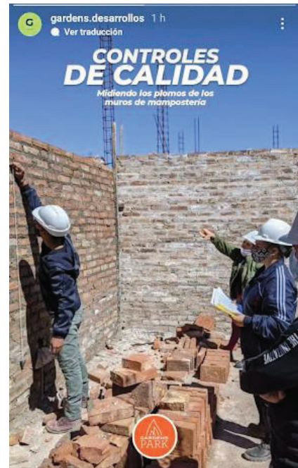
Figura 21. Publicidad de Gardens Desarrollo de control realizado en obra (plomada)
