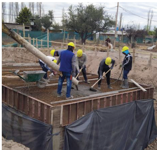
Figura 6. Hormigonado de losa de sala de máquinas
