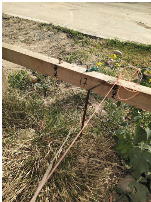
Figura 15. Demarcamiento de muro y eje mediante tanzas en el caballete de replanteo
