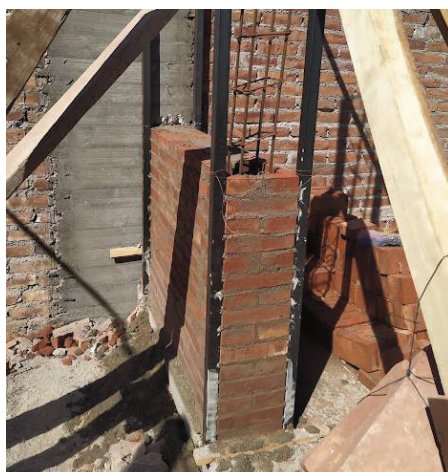
Figura 22. Muros de mampostería en construcción con sus reglas metálicas y tanzas guía
