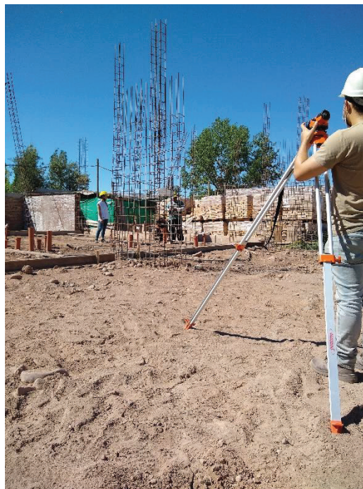
Figura 30. Toma de nivel de contrapiso con nivel óptico y mira estadimétrica
