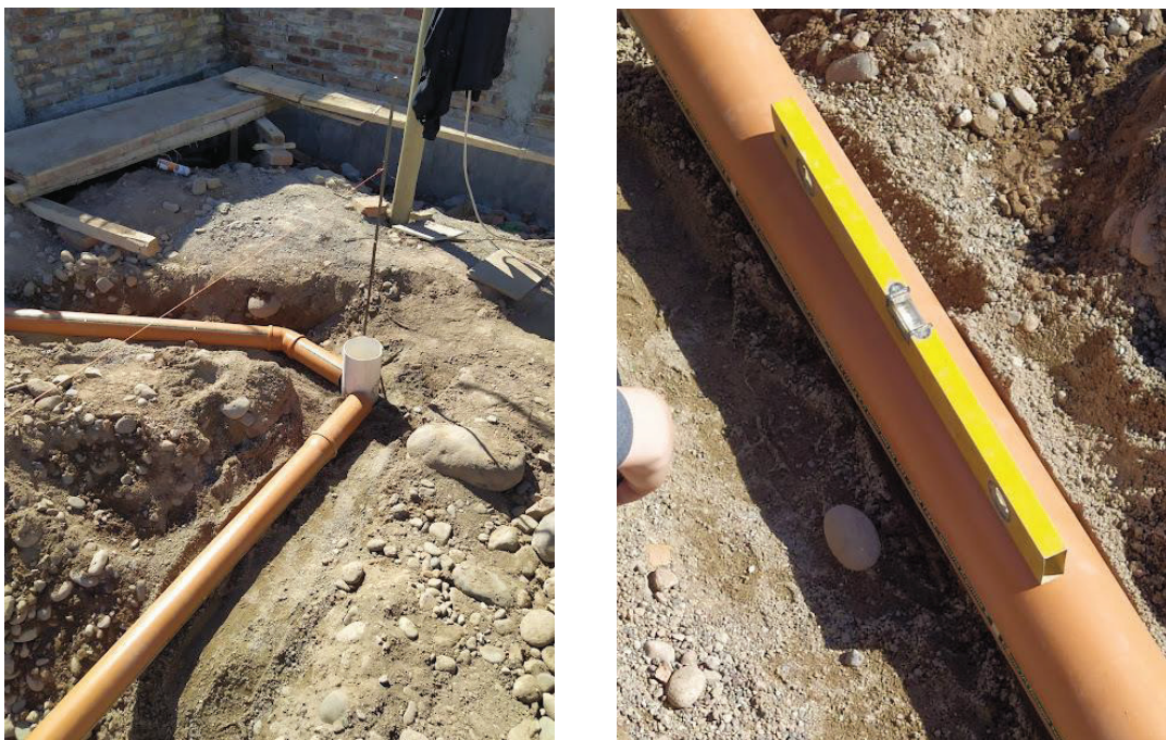
Figura 32. Control de desnivel de desagüe pluvial
