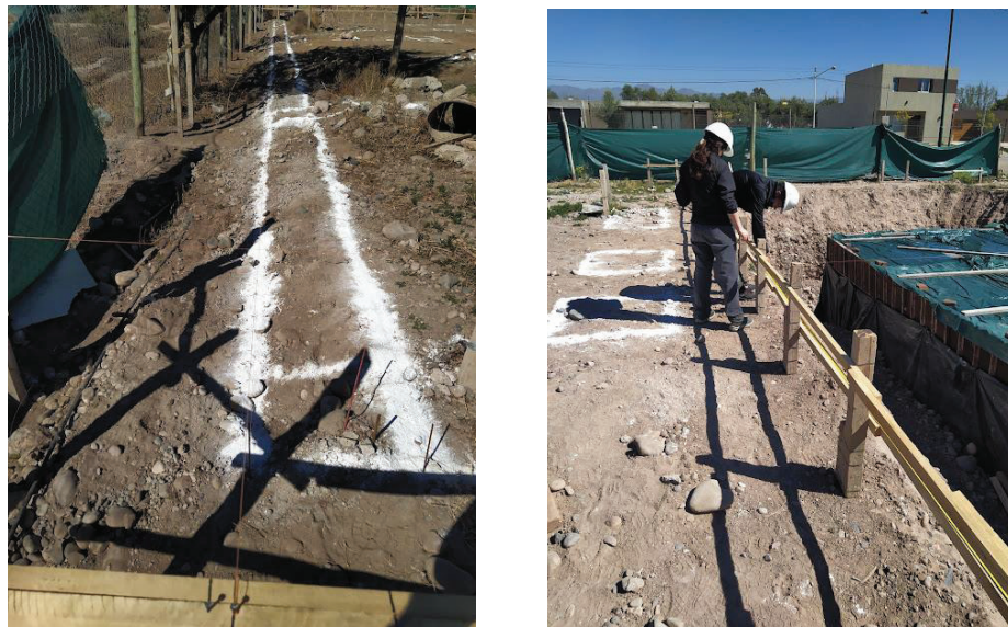
Figura 16. Replanteo demarcado con cal y caballetes
